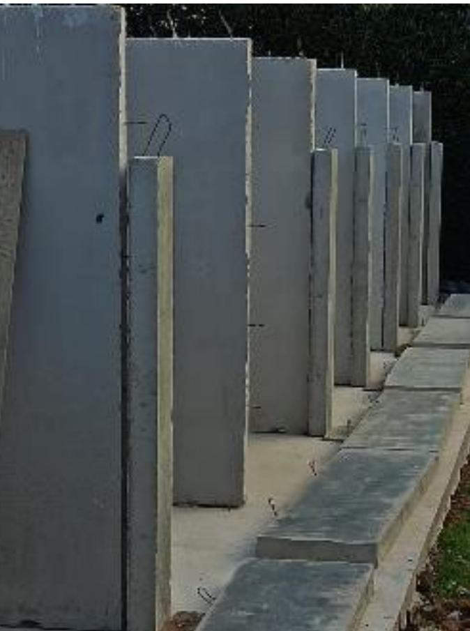
O Muro produzido e fornecido pela MASTERTECH, é composto de concreto armado cuja armadura de aço padrão com vergalhão nervurado em formato de tela 20x20 e bitola 5/16", com 8cm de espessura. A altura e comprimento são ajustáveis de acordo com o detalhamento de cada projeto.
