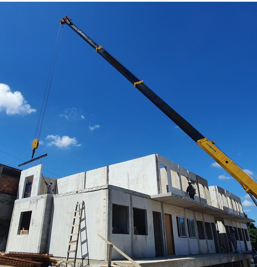
Os elementos alveolares MASTERTECH de paredes, eliminam a necessidade de embolsos ou esticamentos, sendo confeccionados na fábrica sob medida, prontas para receber tratamento e pintura. Os módulos de parede MASTERTECH possuem as seguintes dimensões: Pé direito de 2,8m, Espessura de 13cm e comprimento de acordo com os vãos do projeto.
